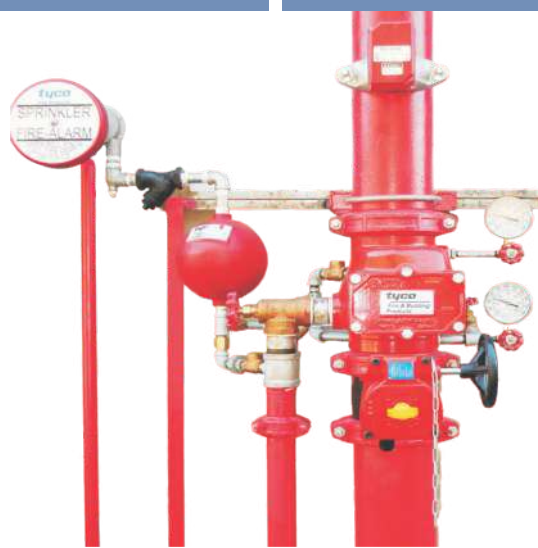
Válvula de Retenção de Prumada
